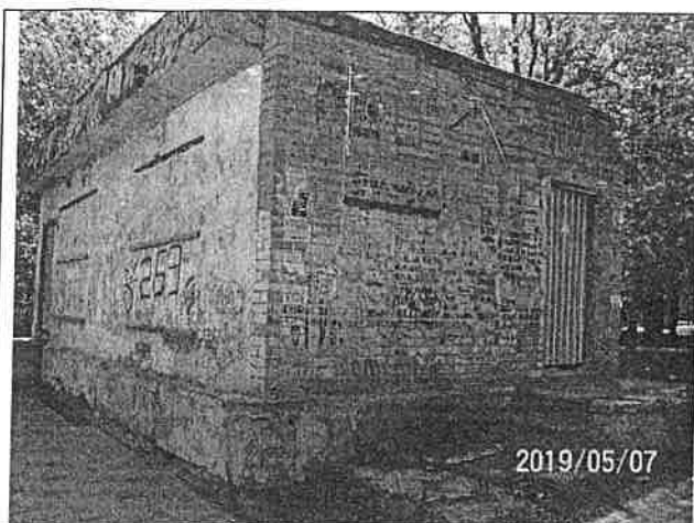
Рис. 4.5 Состояние цокольной части стен и фундамента. Обрушение защитного слоя цоколя, размораживание бетона фундаментных блоков.
