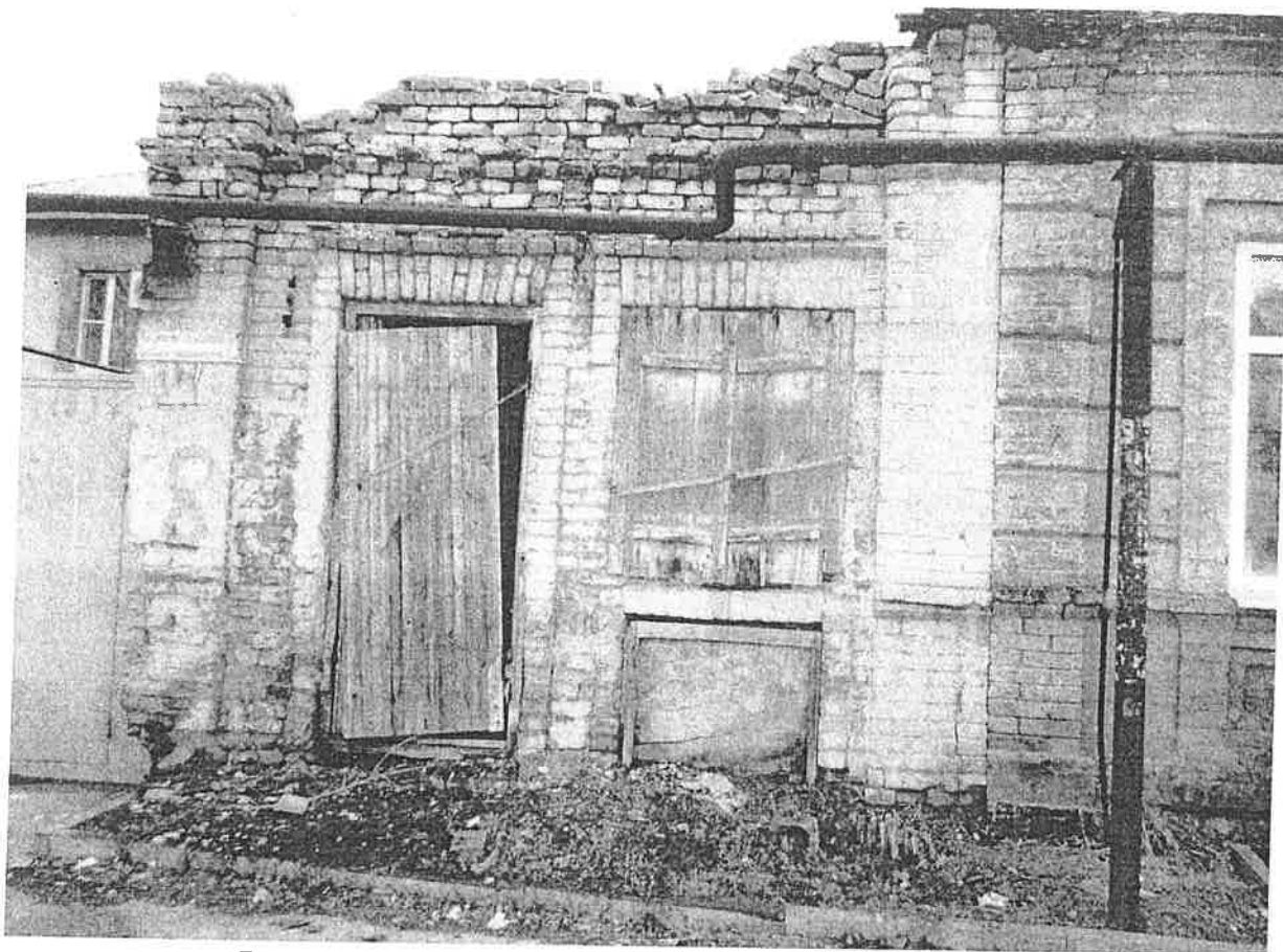
Рис. 4.1 Общий вид здания с улицы Республиканской
