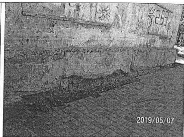
Рис. 4.5 Состояние цокольной части стен и фундамента. Обрушение защитного слоя цоколя, размораживание бетона фундаментных блоков.
